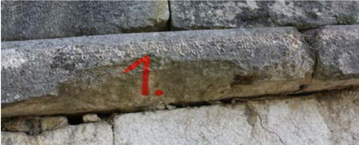
Abb. 72 Foto vom Brückenuntersichtsgerät auf Reinacherseite, flussauf. Auswechslung erfolgt in der zweiten Bauphase, sobald das Gerüst umgestellt ist.
