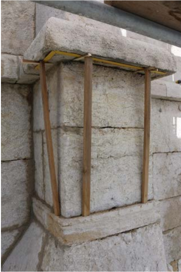
Abb. 87 Schalung der Wassernasen-Spitznuten
