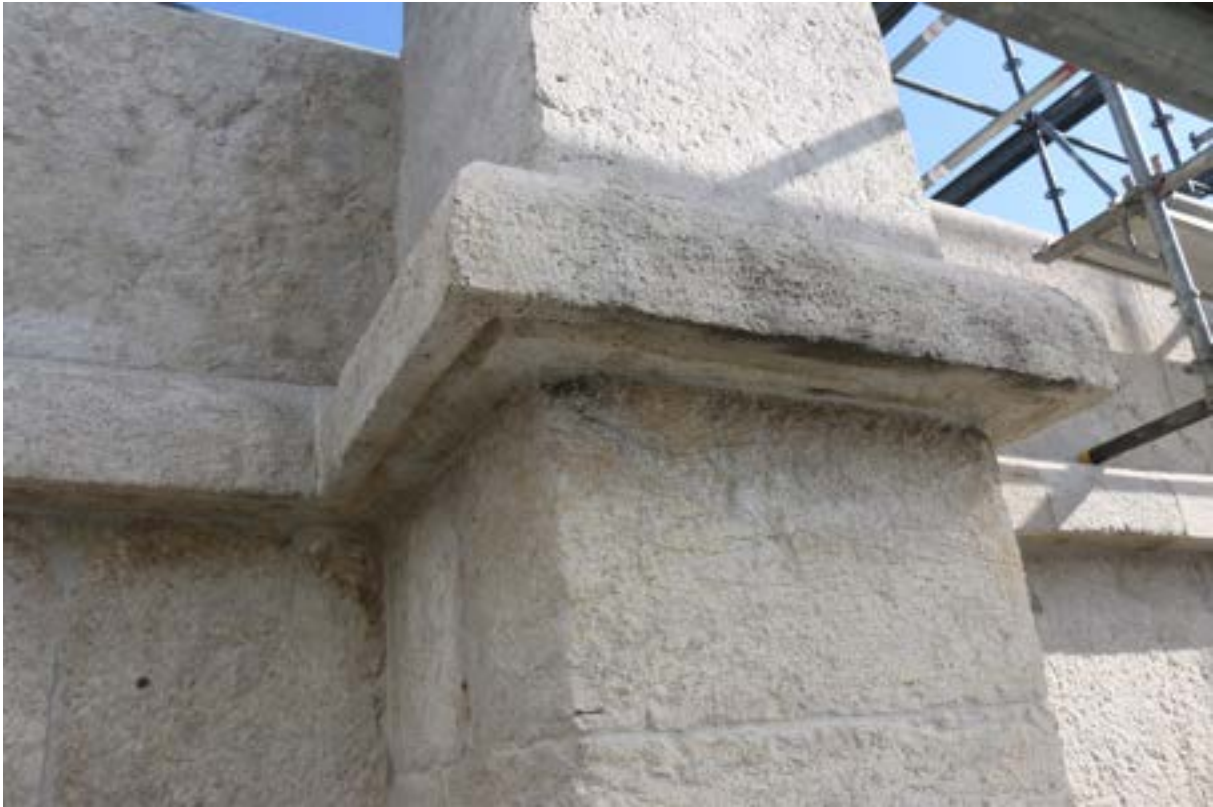
Abb. 89 mit durchgezogener Wassernase
