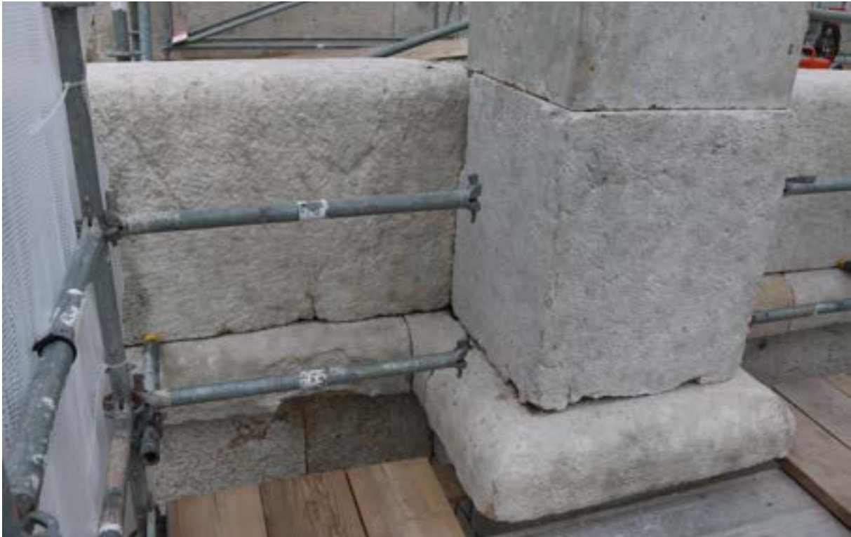
Abb. 85 Neposockel und angrenzendes Gurtstück nach der Reinigung, vor dem Flickern
