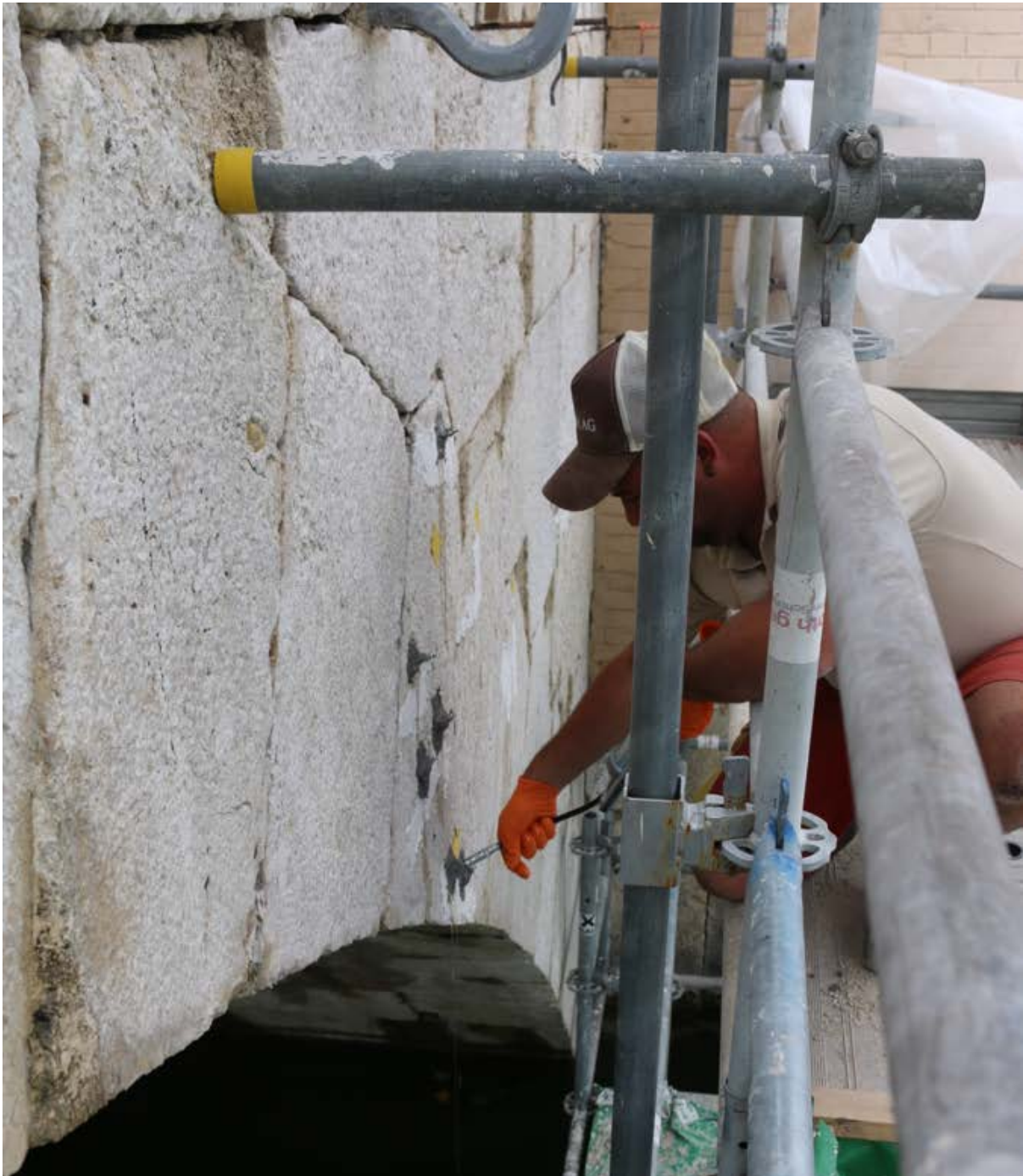
Abb. 92 Beim Einpressen der Epoxydharzflüssigkeit
