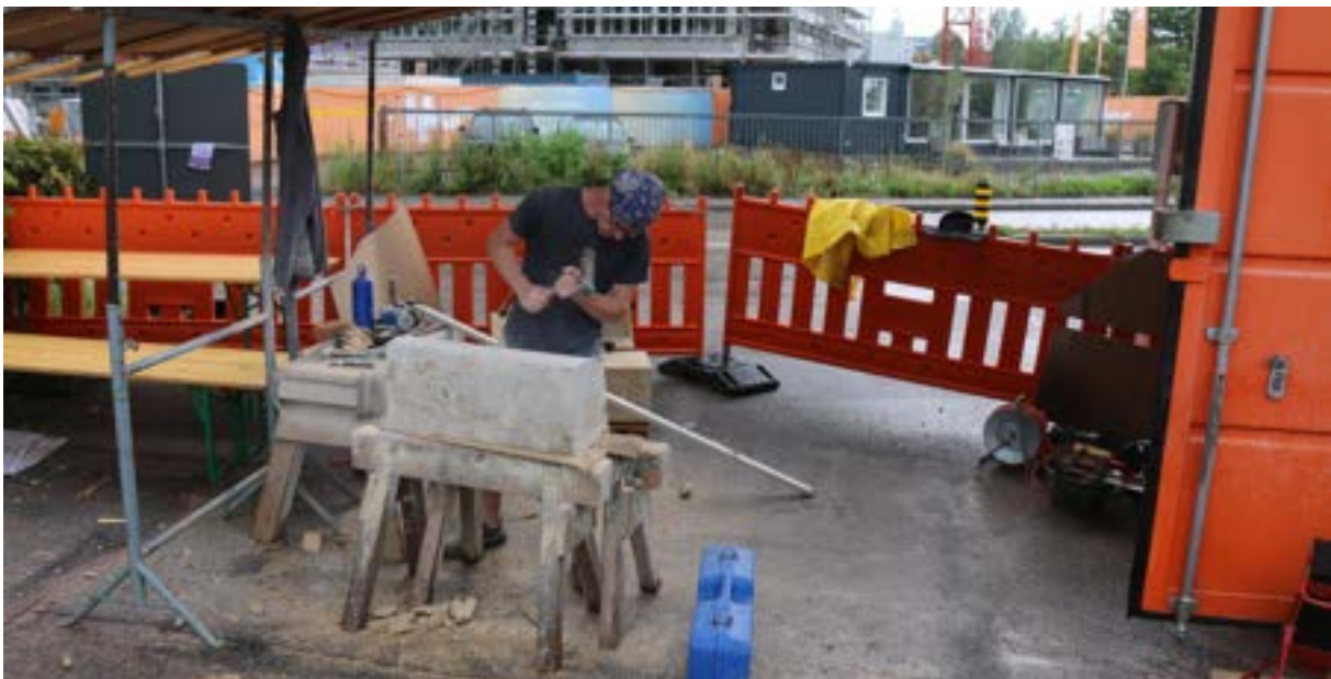
Abb. 51 Arbeit an Gurtersatzstücken
