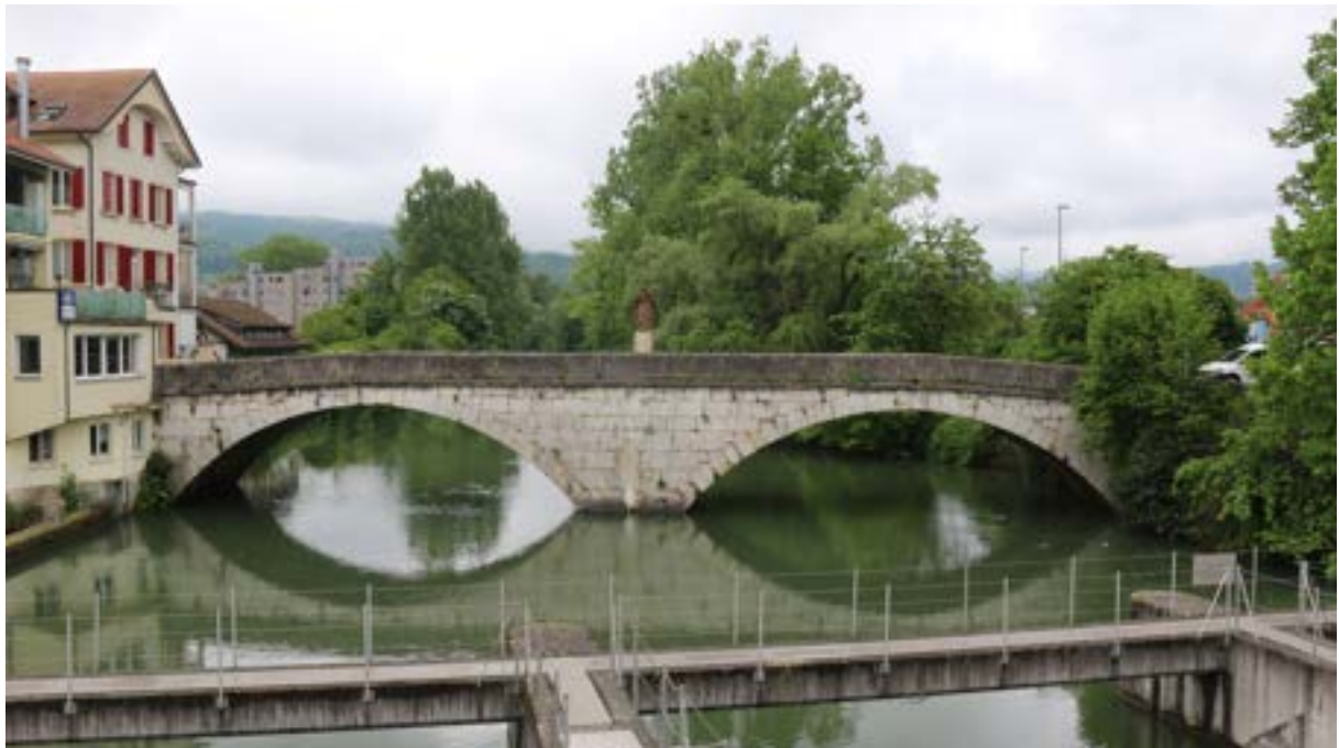
Abb. 1 Vorderseite, Zustand Mai 2023, vor den Sanierungsmassnahmen
