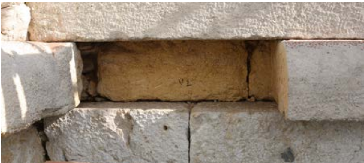
Abb. 53 Um kleine Klötzchen zu vermeiden, haben wir zum Teil Vierungen über Fugen hinweg geführt ;-)
