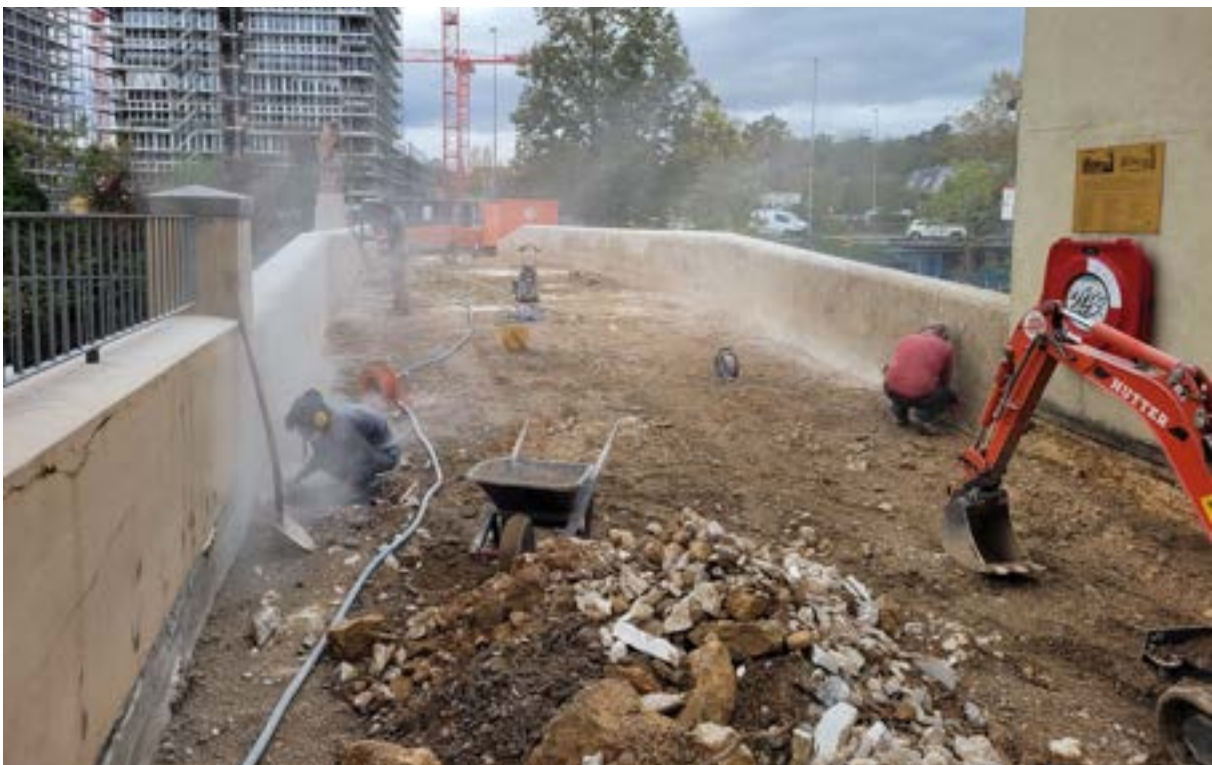
Abb. 101 Das abgetragene Material liegt im Vordergrund.
