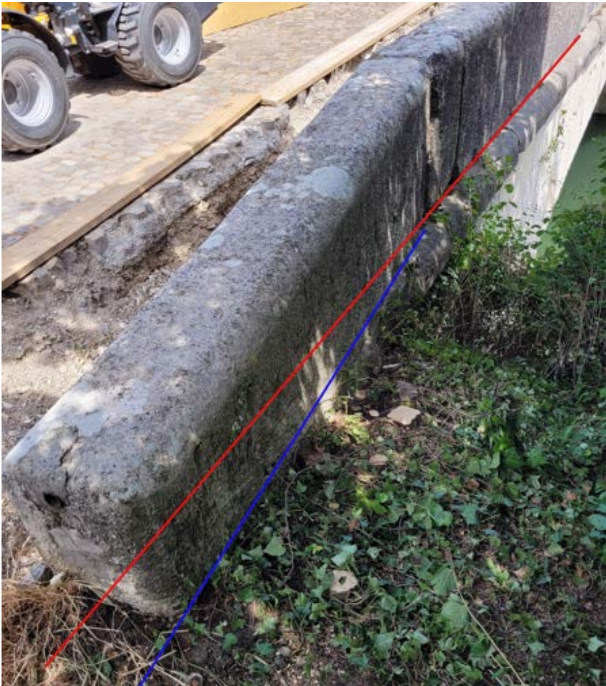
Abb. 26 Rote Linie= Flucht UK Brüstungen, blaue Linie = UK nach aussen geschobener Stein
