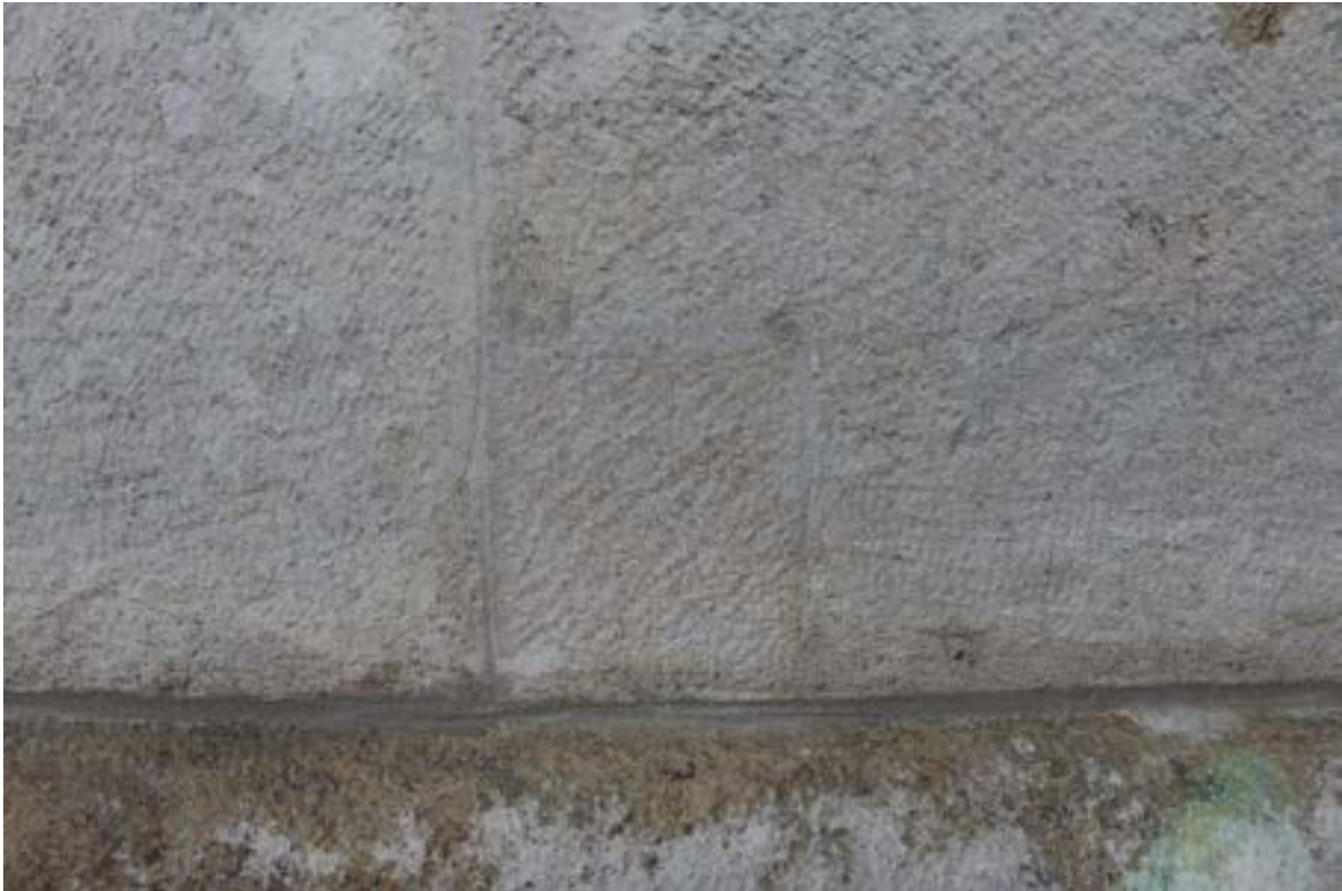
Abb. 76 eingesetzte neue Vierung, Ecke des links angrenzenden Steins und die Brüstungsunterkanten aufmodelliert
