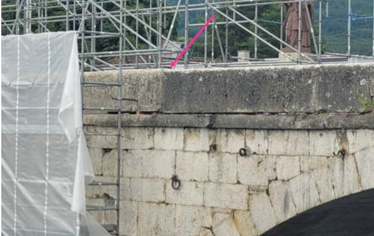
Abb. 43 Der Versatz ist zu erkennen zwischen heller, gedampfter und dunkler, ungereinigter Brüstung
