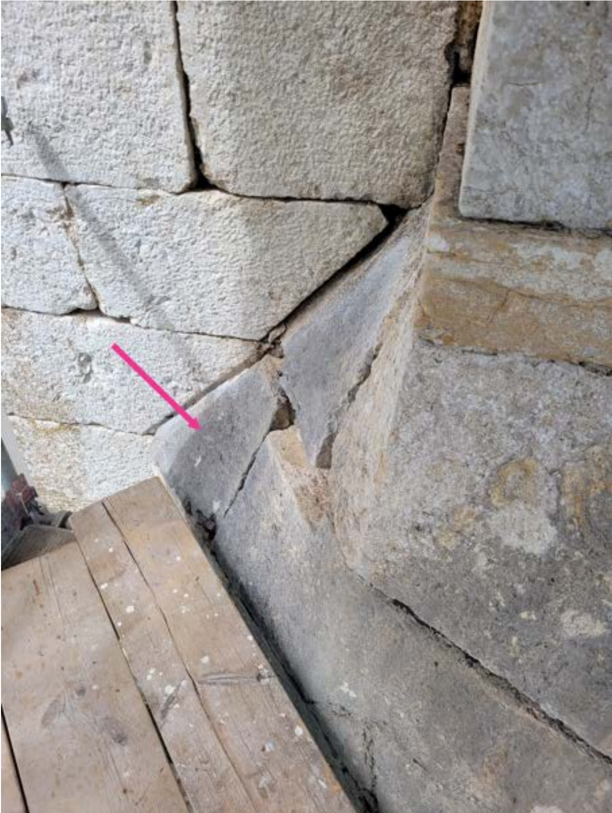
Abb. 42 Nach dem Wiedereinbau
