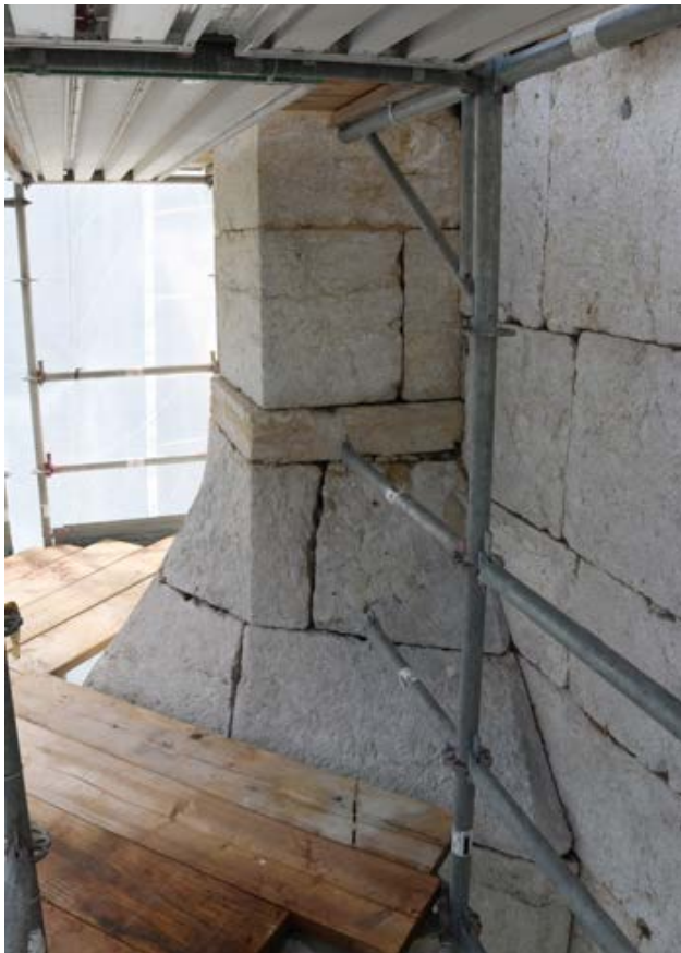
Abb. 81 man hätte die Fugen so aufgefranst sein lassen können wie im Bild und direkt mit Fugenmörtel schliessen können. Das hätte aber z.T sehr breite Fugen ergeben und sie damit in den Vordergrund gerückt.
