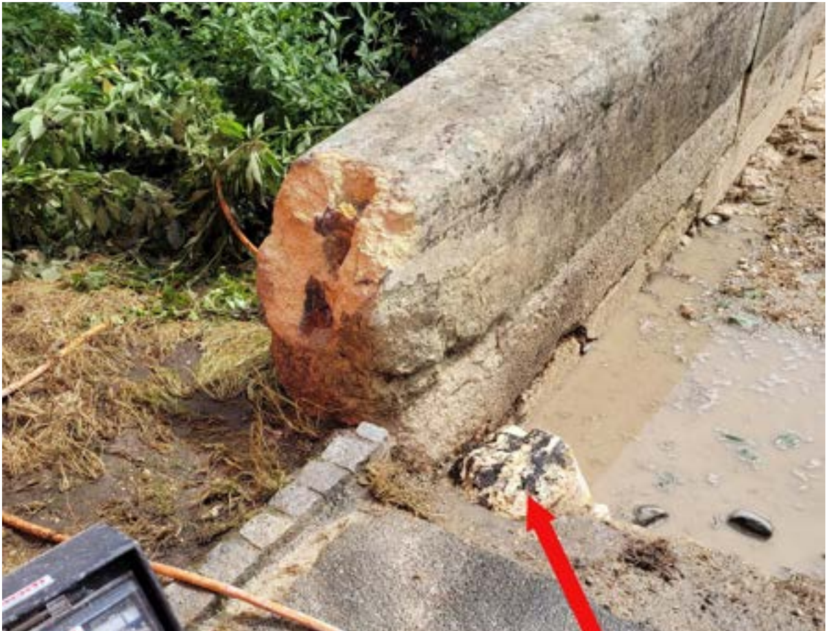
Abb. 37 Der rote Pfeil zeigt auf einen alten Radabweiserstumpf.
