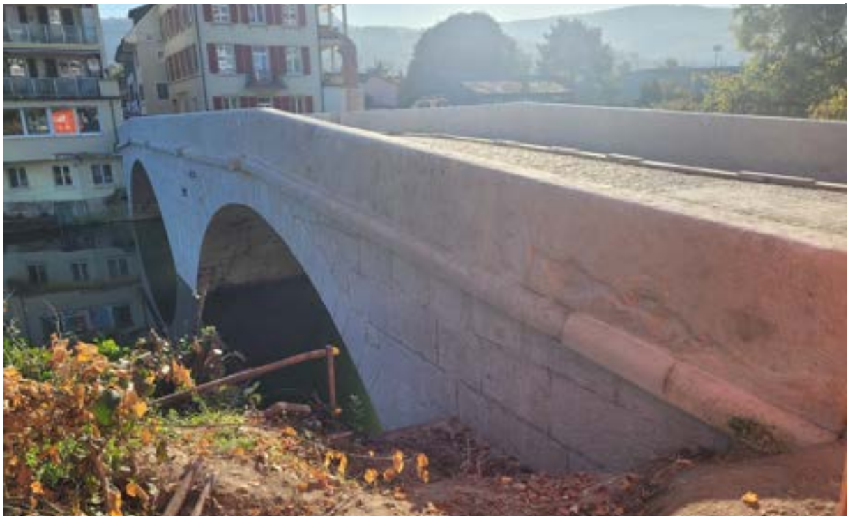
Abb. 2 Nach der Sanierung, Oktober 2023
