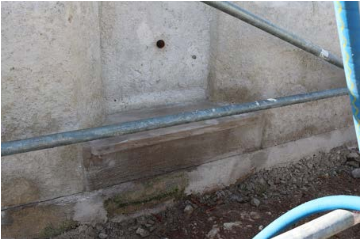
Abb. 34 Die Reste der Deckplatte sind entfernt, das Profil ergänzt, die Risse zugeschlemmt. Jetzt werden zuerst Brückenabdichtung und Strassenbelag eingebracht und dann die neue Platte auf den Stufenunterbau gesetzt.
