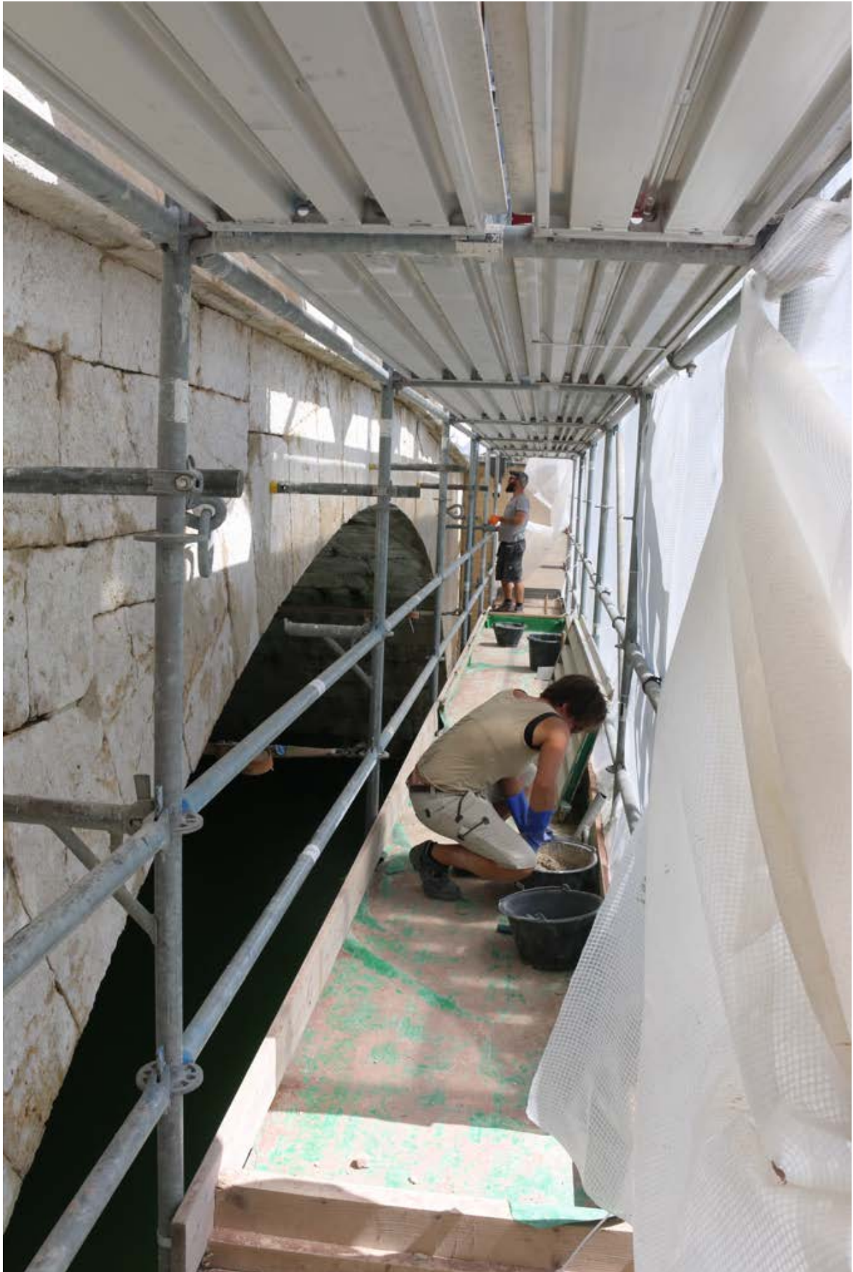
Abb. 84 Mörtelarbeit flussauf
