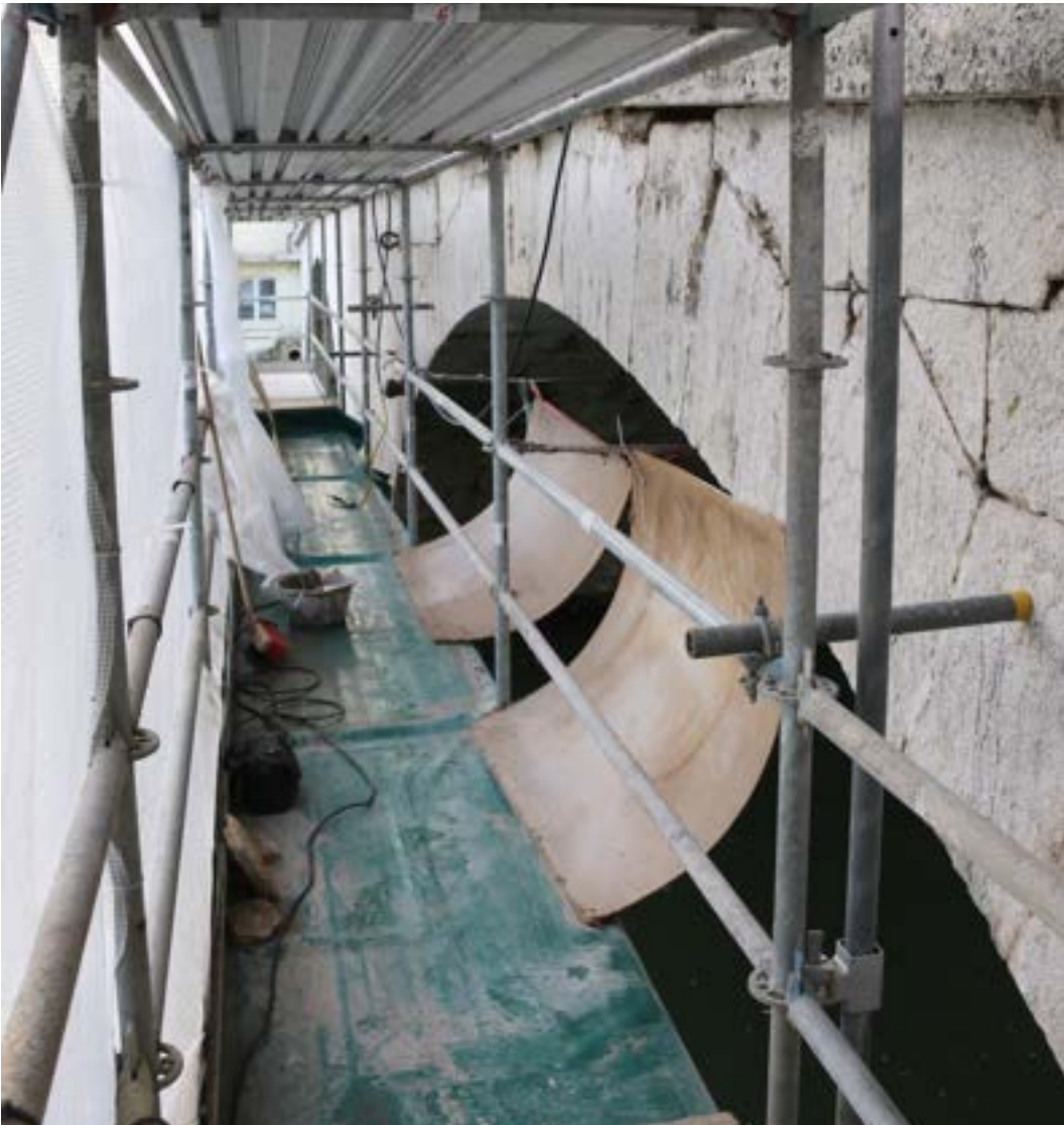
Abb. 98 Hartfaserplatten dienen als Rutsche für den Schutt während des Aushauens/ -bohrens. Jetzt kann gesandstrahlt werden... (Sicht flussab, Richtung Dornach)
