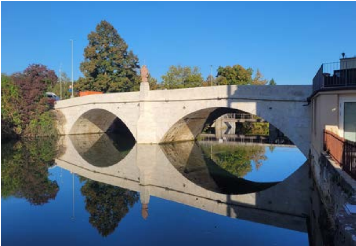
Abb. 4 Nach der Sanierung, Oktober 2023
