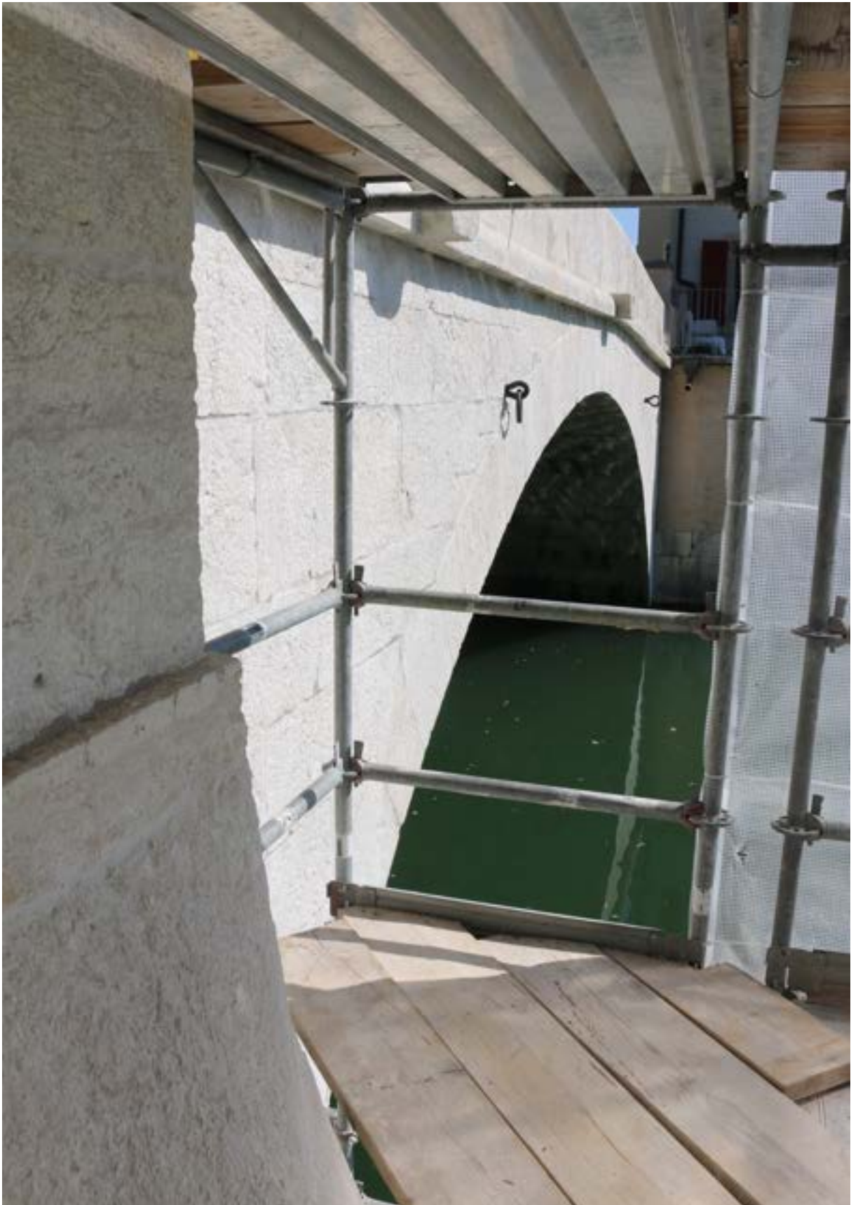
Abb. 94 Ein Blick vom umgesetzten Gerüst auf die fertig sanierte Brückenhälfte auf Dornacherseite.
