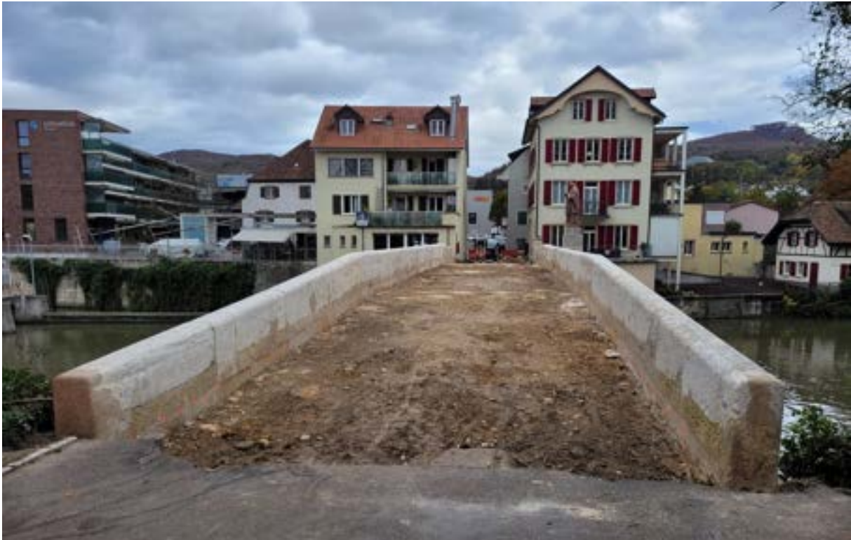
Abb. 102 Bereit für die Pflästerfirma und ihren Magerbeton
