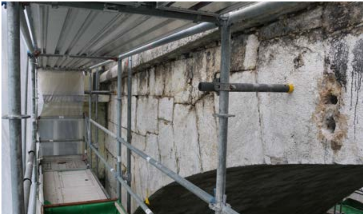
Abb. 5 Hier sind die Eisen bereits ausgebohrt
