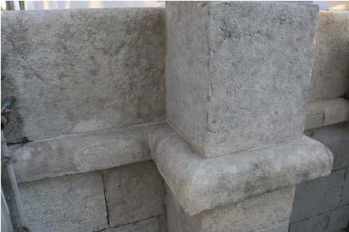
Abb. 86 Nach der Sanierung
