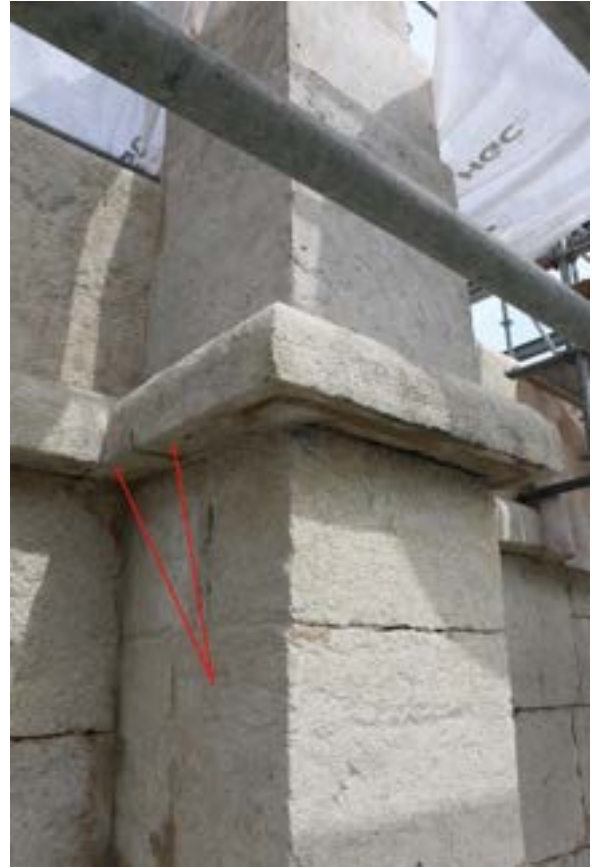
Abb. 88 Nach dem Mörtelantragen. Die Wassernase läuft nicht bis hinten (rote Pfeile). Sie wird von uns bis hinten um die Ecke gezogen, um ihren Dienst zuverlässig zu tun. Auf der sonnenbeschienenen Fläche im Vordergrund sind die geschlammten Partien zu erkennen.
