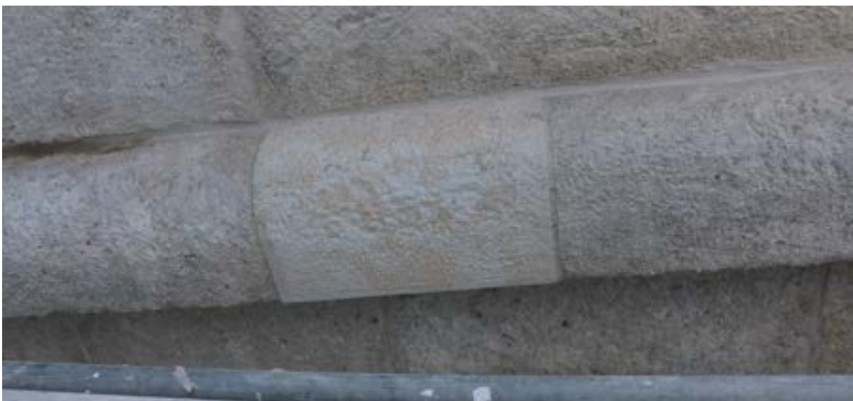
Abb. 71 vom Gerüst aus von rechts oben gesehen
