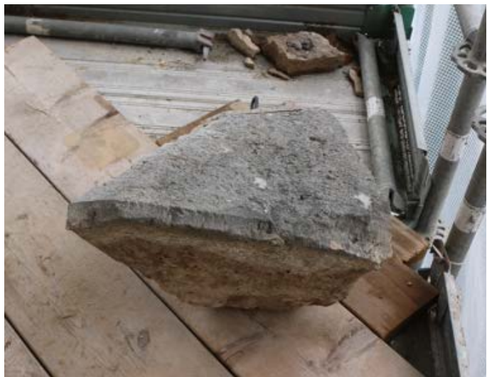
Abb. 41 der ausgebaute und abgedampfte Stein
