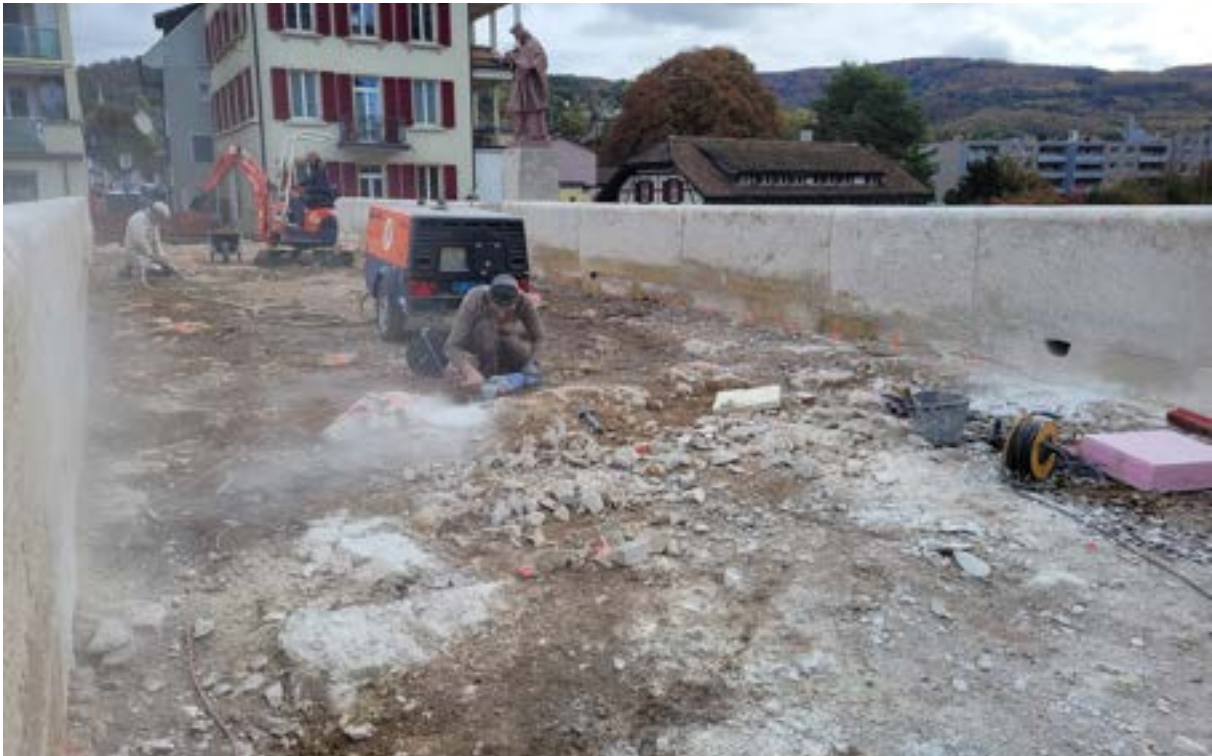
Abb. 100 Mit Leuchtfarbe sind die Buckel angezeichnet und in Zahlen die abzutragende Höhe.
