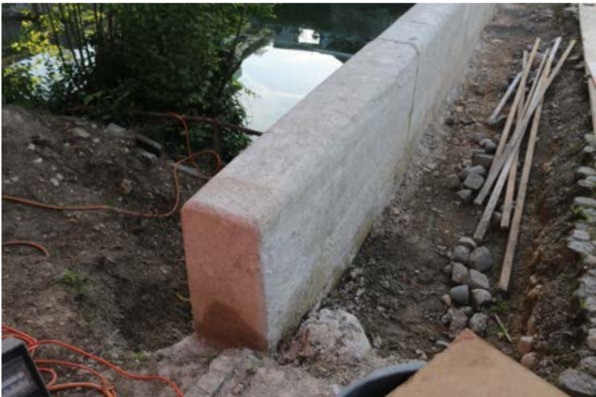
Abb. 38 mit aufmodellierter Ecke
