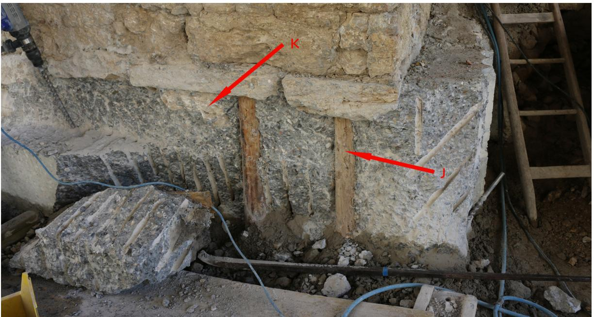
Der „moderne“ Beton am rechten Pfeiler wird steinbruchmässig durch Bohren, Spalten, Fräsen entfernt. Im rechten Bereich kommen drei Baumstämmchen **J** zum Vorschein, mit dem der Stein darüber abgespriesst worden ist. Der dritte Holzspriess wird erst beim Wegspitzen des Betonpaketes rechts zum Vorschein kommen.
