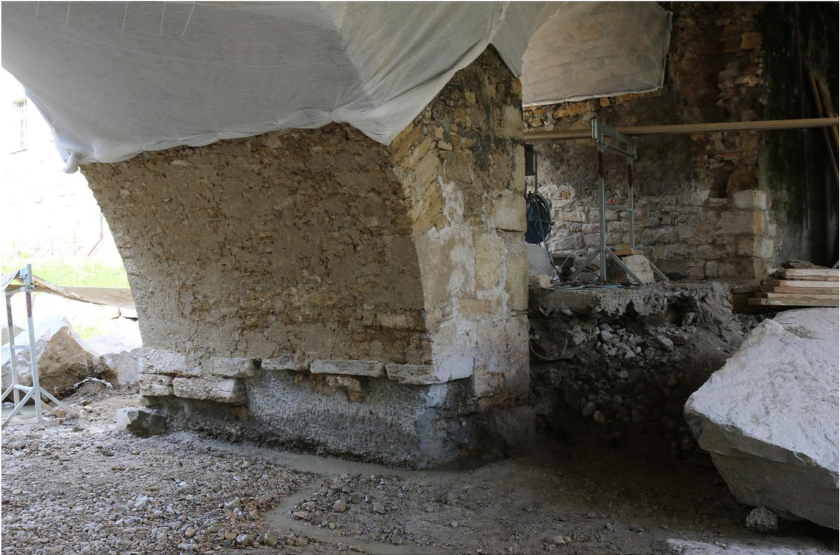
Fugen und nichthomogene Steine der Gewölbefläche sind mit Grundiermörtel soweit zugeworfen, dass eine haltbare, hochwasserfeste „Verschleisschicht“ entsteht. Der Betonsockel ist hier jetzt auch an der Brückenfront zurück gearbeitet. Die Lücke ist bereit zur Aufnahme der neuen Sockelsteine.
