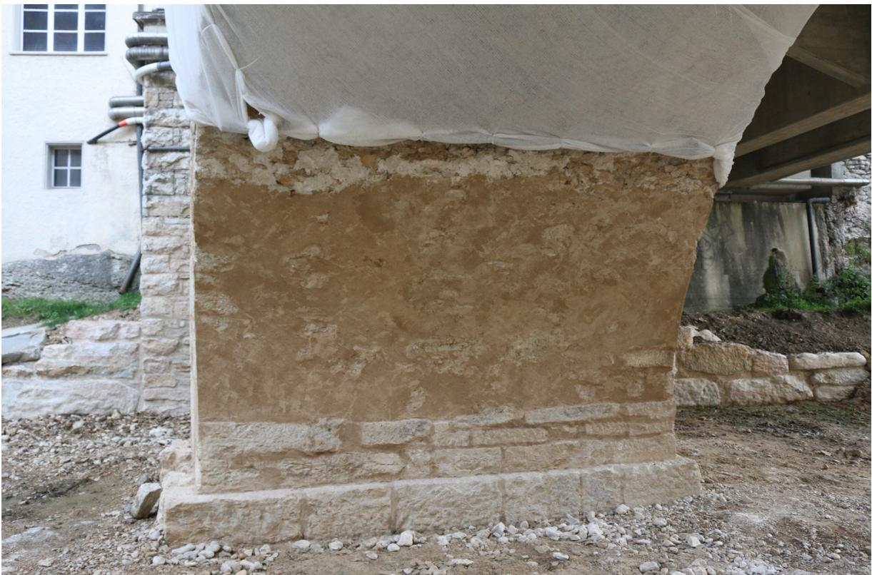
Der Deckmörtel ist angebracht, der Sockel (als einziges, wegen der Schichthöhe, aus zugeführtem Material) eingebaut.
