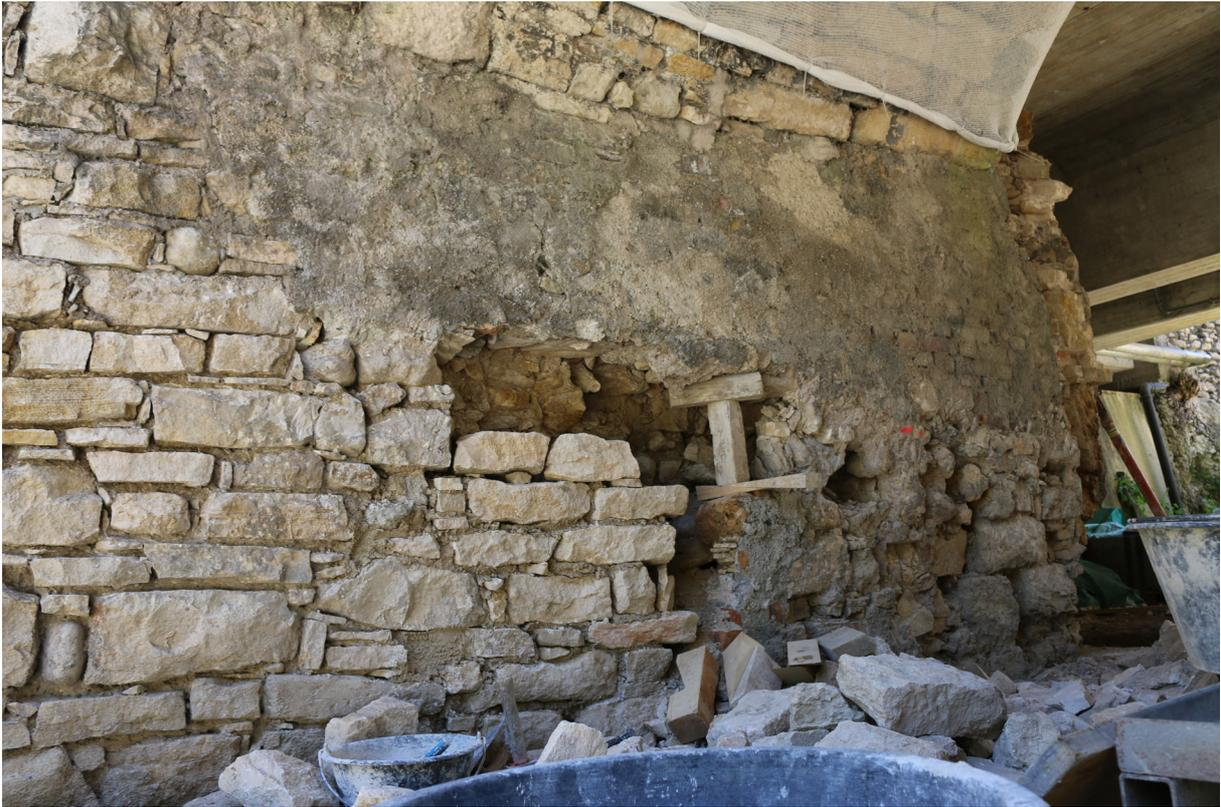
Schlechtes, erfrorenes Material und Backsteine im Bereich des kleinen Gewölbes werden schrittweise entfernt und durch gutes Material ersetzt.
