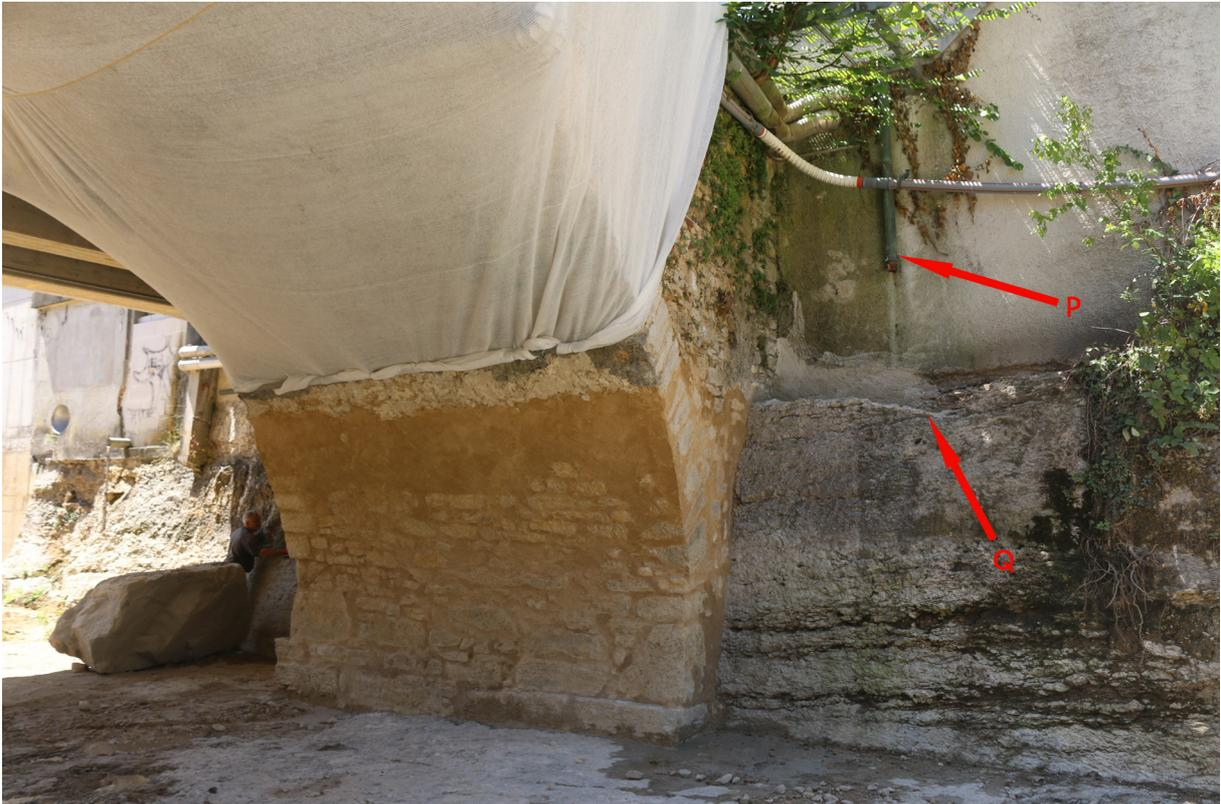
Das Regenrohr **P** wird bauseits nach rechts verlängert, damit das Dachwasser des Nachbarhauses von der Brücke weg abfließt. Die Felsoberkante haben wir nach rechts abfallend zurück gespitzt und die bröckelige Oberfläche mit Mörtel stabilisiert. Anfallendes Meteorwasser fließt nun von der Brücke weg und über den tiefsten Punkt **Q** ab.
