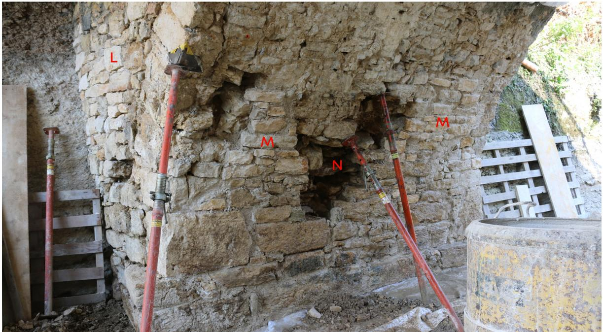
Die Frontmauer **L** ist ergänzt, Gewölbepartien **M** aufgemauert, und damit tragend. Der restliche Beton **N** entfernt. Dieses Loch kann jetzt ausgemauert werden.
