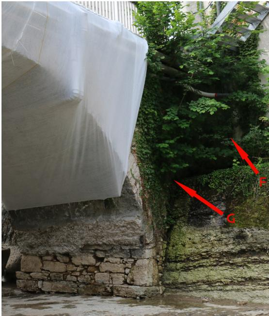
Auf der Rückseite des linken Pfeilers fällt ein beträchtlicher Teil des Dachwassers des Nachbarhauses aus einem Fallrohr (F) auf den Felsen darunter, fließt wegen dessen Linksneigung Richtung Brücke und durchnässt ab Bereich G, und von dort bis ins Gewölbe hinein die Brücke.
