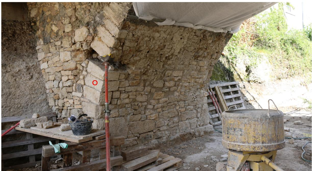
Die Gewölbefläche ist geschlossen. Die bröckeligen Ecksteine sind entfernt und durch gutes Material
