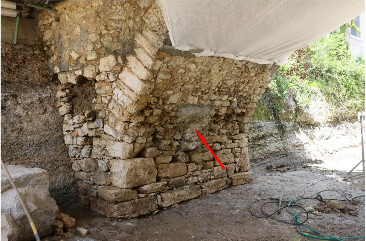
Die Fugen sind ausgehauen und hochdruckgereinigt. Der Mittelbereich des Betons (Pfeil) bleibt vor Ort, bis die Partien links und rechts davon ausgemauert sind. Links im Bild ist ein Teil der labilen Frontfläche entfernt worden. Der „Mörtel“ im Inneren, in diesem Bereich, besteht teils aus lehmiger Erde, teils aber auch aus Humus. Die Füllungssteine im Inneren sind immerhin dicht auf dicht, mindestens punktuell, versetzt worden.
