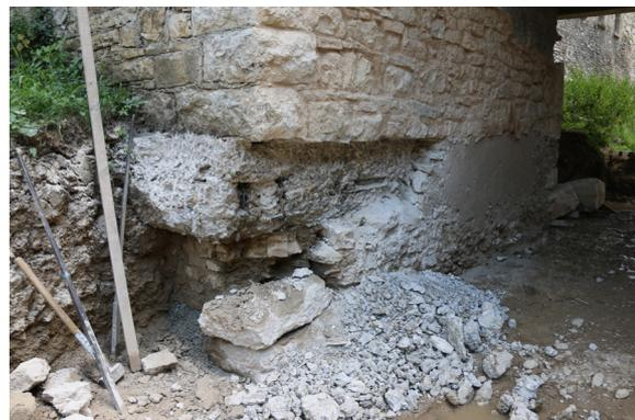
Im Betonfundament der Mauerecke neueren Datums kommen eine Menge Stahlträger zum Vorschein, die soweit entfernt werden, dass Raum für die Vormauerung aus Naturstein entsteht.
