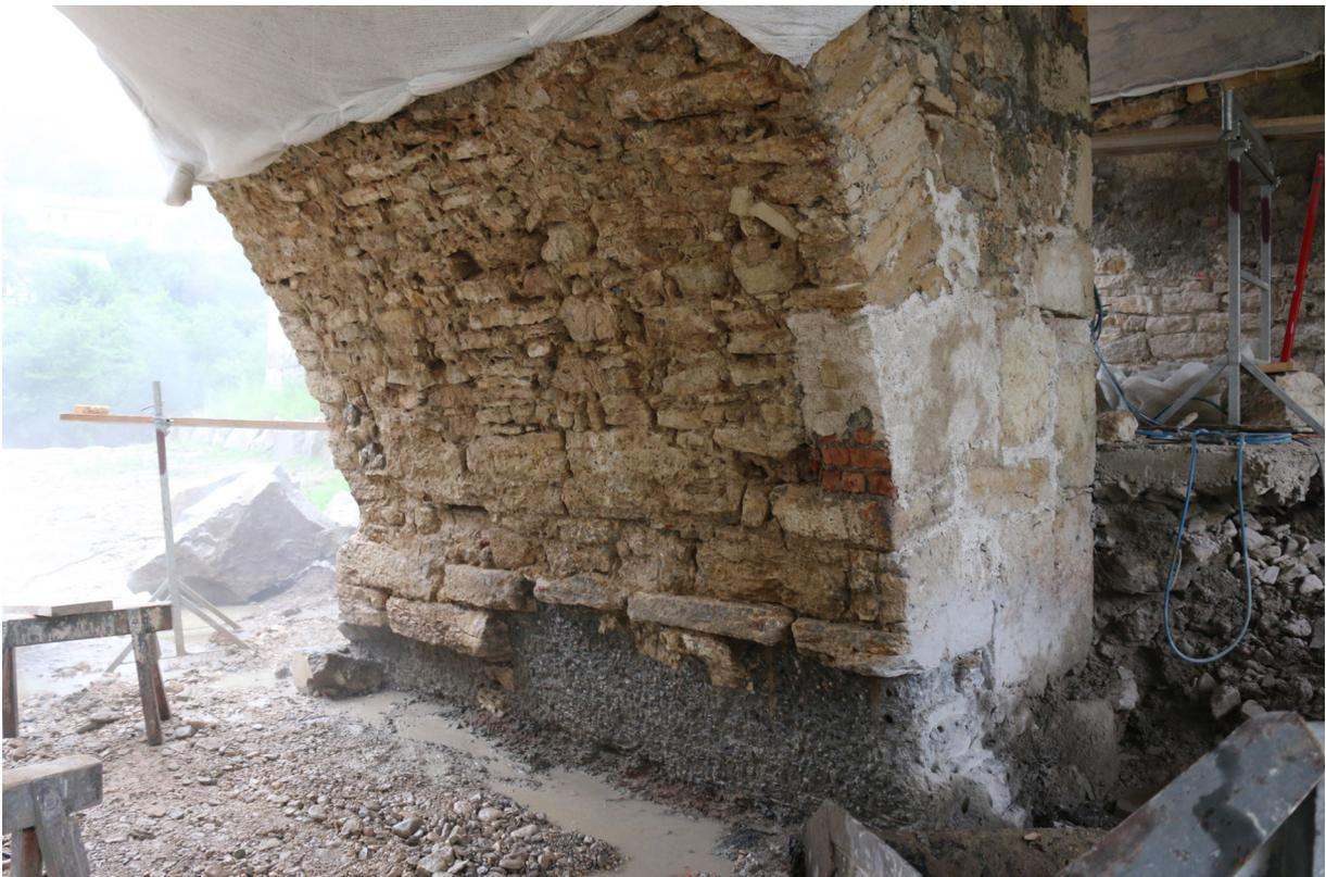
Die Fugen der Gewölbefläche sind ausgehauen und gereinigt, der Beton unten zurück gearbeitet.
