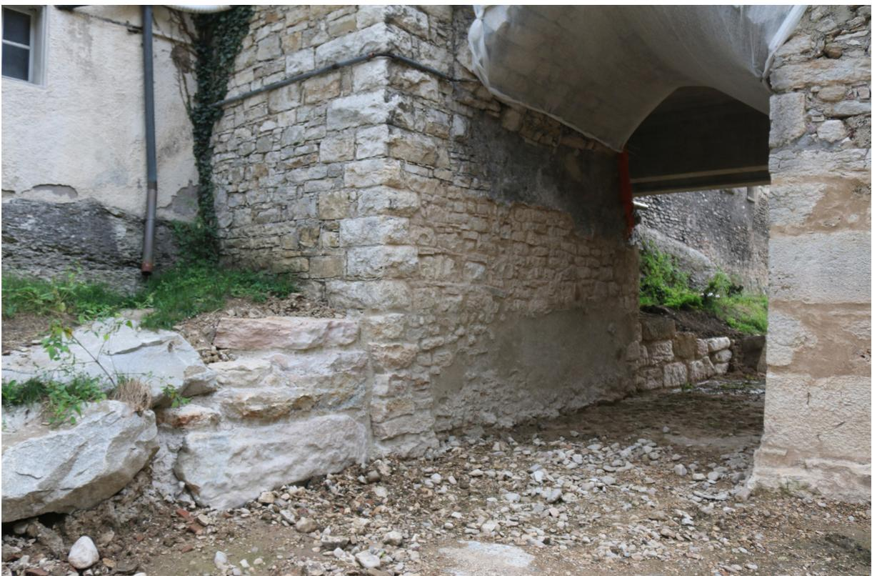
Als Hochwasserabweiser versetzen wir links und rechts des östlichen Pfeilers Kalksteine, die gleichzeitig einen Übergang schaffen zwischen Kalksteinbrücke und granitiger
