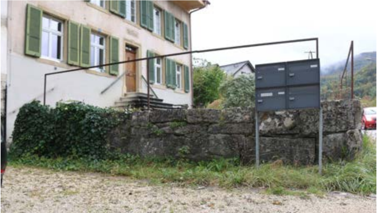
Abb. 3 ca. sechs Meter Mauer, ab Fassade, bleiben stehen
