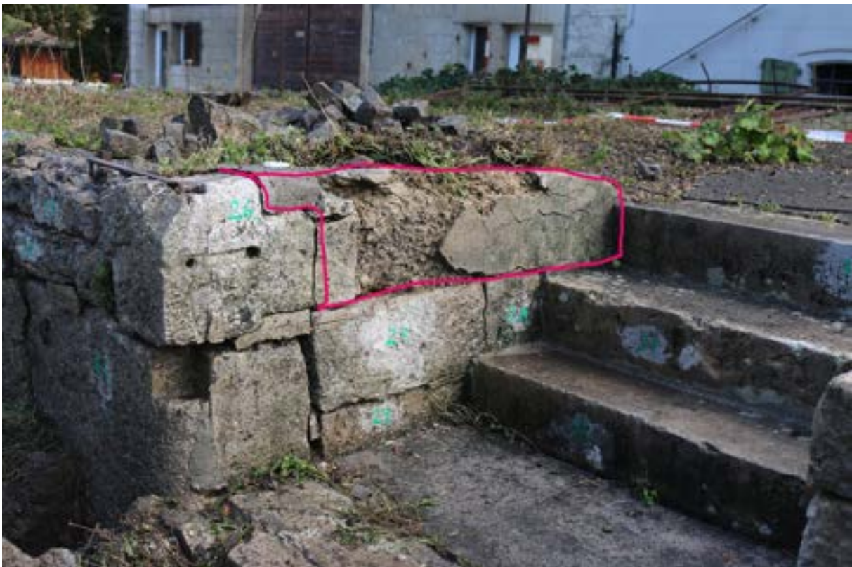
Abb. 9 Hier besteht das pinkfarben umrandete Material aus verwittertem Beton und wird entsorgt.
