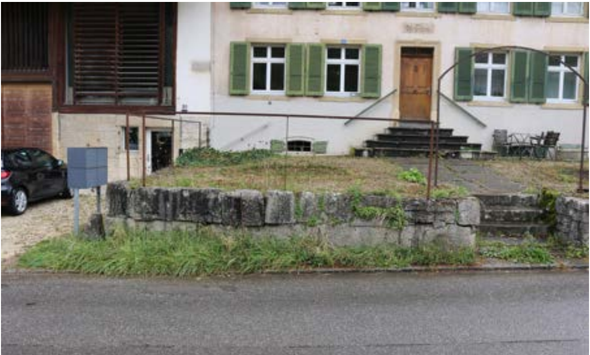
Abb. 4 Das Terrain (Vorplatz, Asphalt) wird an der Mauerecke links im Bild neu 19 cm höher gesetzt. Die Mauerkrone wird 10 cm angehoben.
