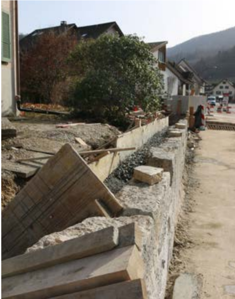
Abb. 20 Beinahe die gesamte Länge steht. Der Sickerbeton ist hinterfüllt
