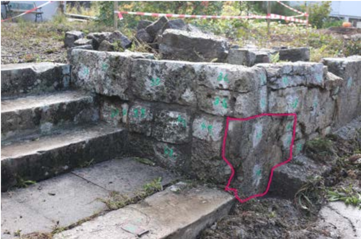
Abb. 10 Alle grösseren Steine haben stehende Lager. Bei diesem pinkfarben bezeichneten Stein fällt eine etwa 10 Zentimeter dicke Schicht ab und zerbricht in Einzelteile. Dieser Stein wird selbstverständlich auch nicht wieder eingebaut.
