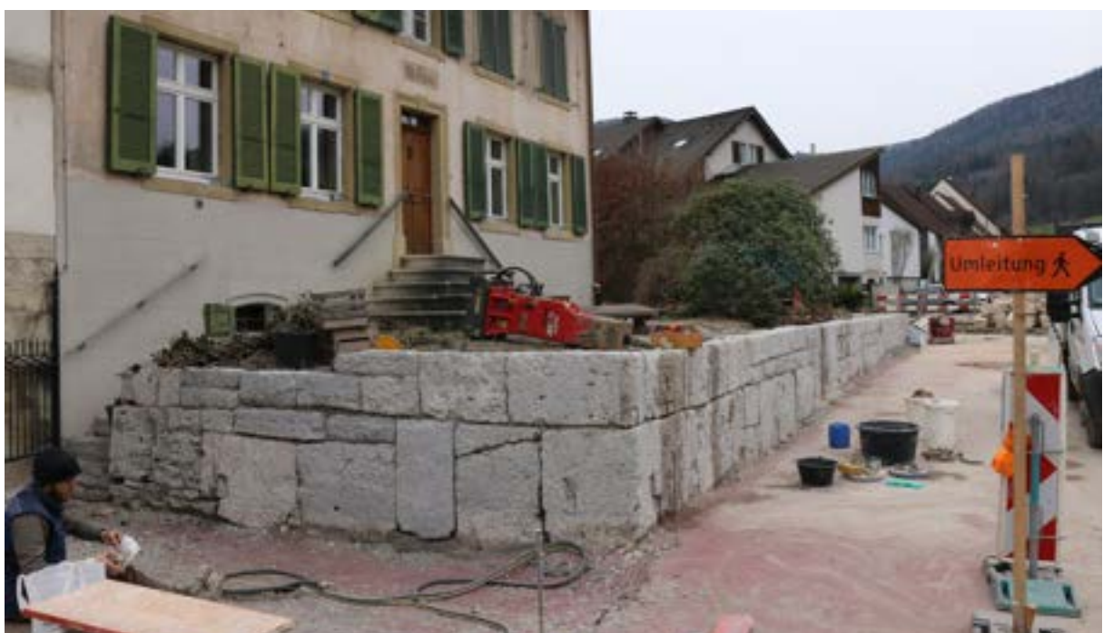
Abb. 2 Nach Abschluss der Arbeiten
