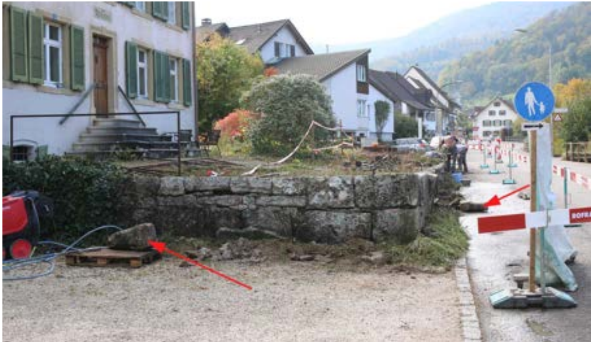
Abb. 1 Vorzustand am Abbautag, die Radabweiser (rote Pfeile) sind bereits demontiert
