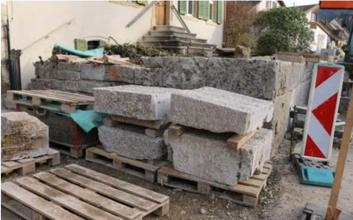
Abb. 22 Die zugehauenen Steine aus "neuem" Material.
