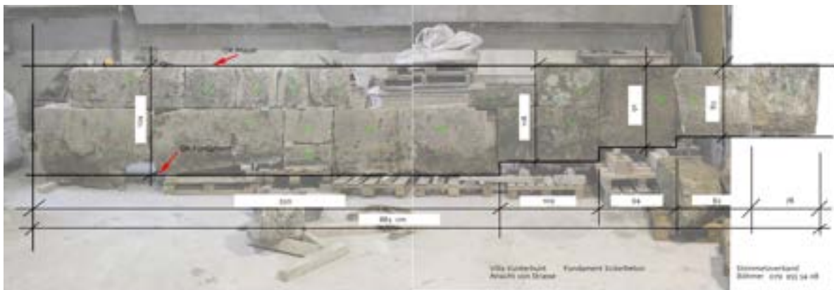
Abb. 15 Die Standfuge von Stein Nr. 20, ganz links unten, wird noch gerade geschnitten, um das Versetzen zu vereinfachen.
