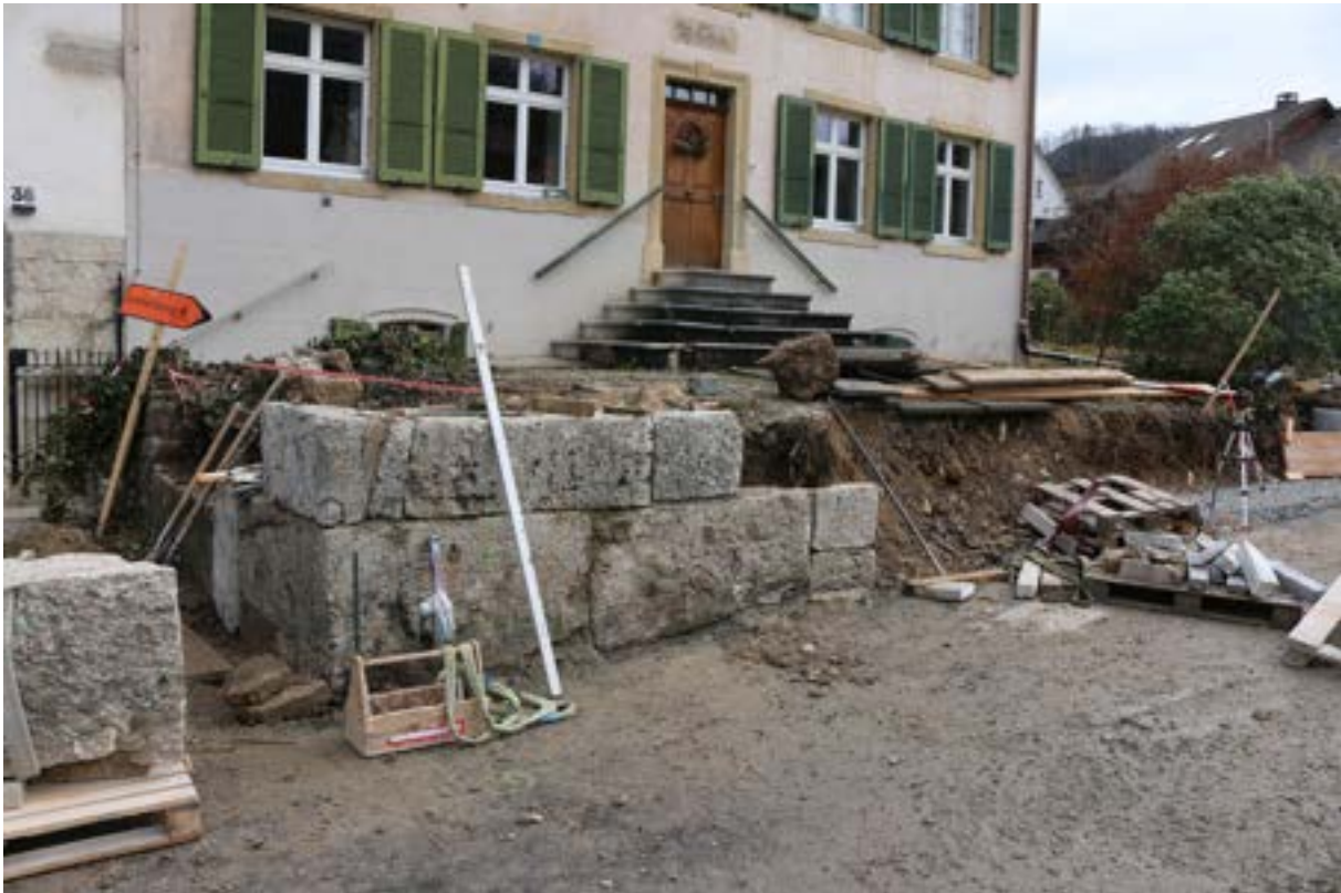
Abb. 18 Die neuerrichtete Mauerecke
