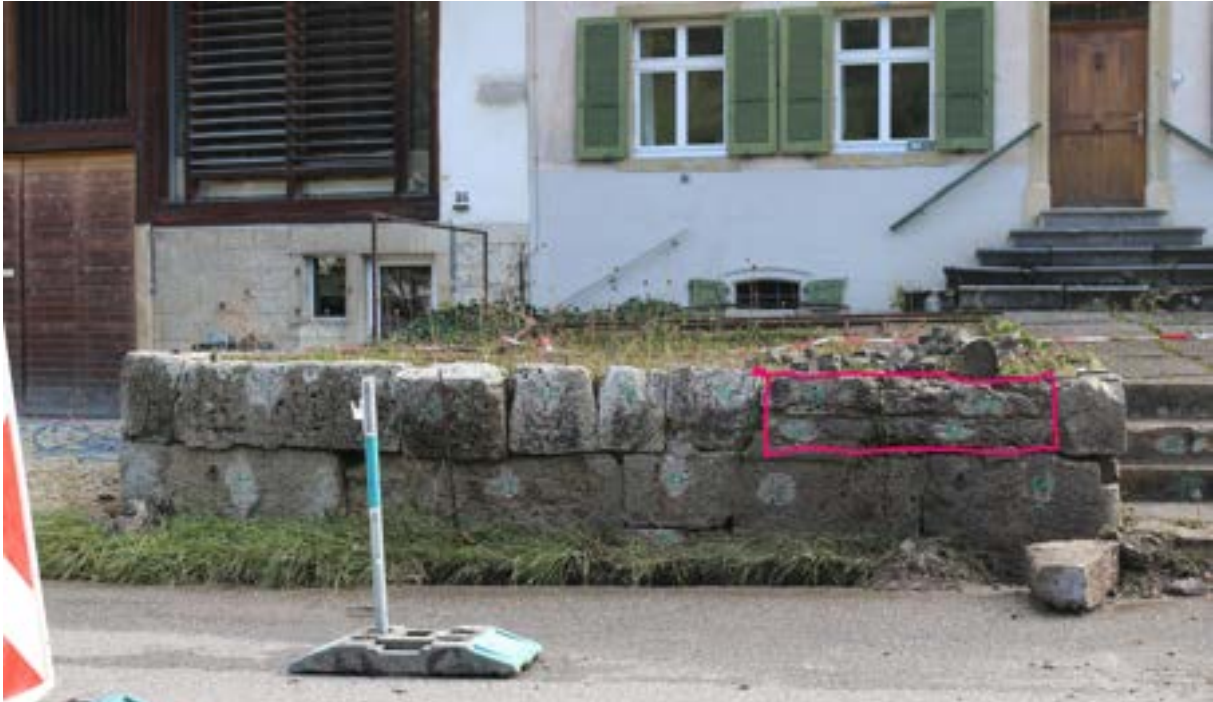
Abb. 8 Das pinkfarben umrandete Material ist in schlechtem Zustand und wird aussortiert.
