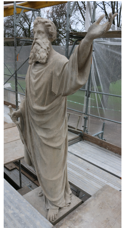
Abb. 44 nach Abschluss der Massnahmen
