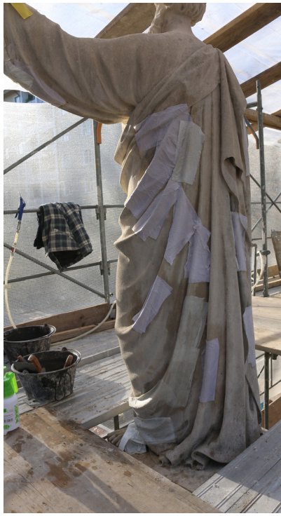
Abb. 43 geschlossene Fehlstellen werden feucht gehalten
